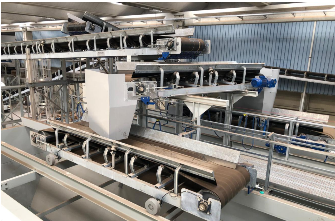
Sistema di esecuzione miscele diversificate di terreno vegetale e fertilizzanti
